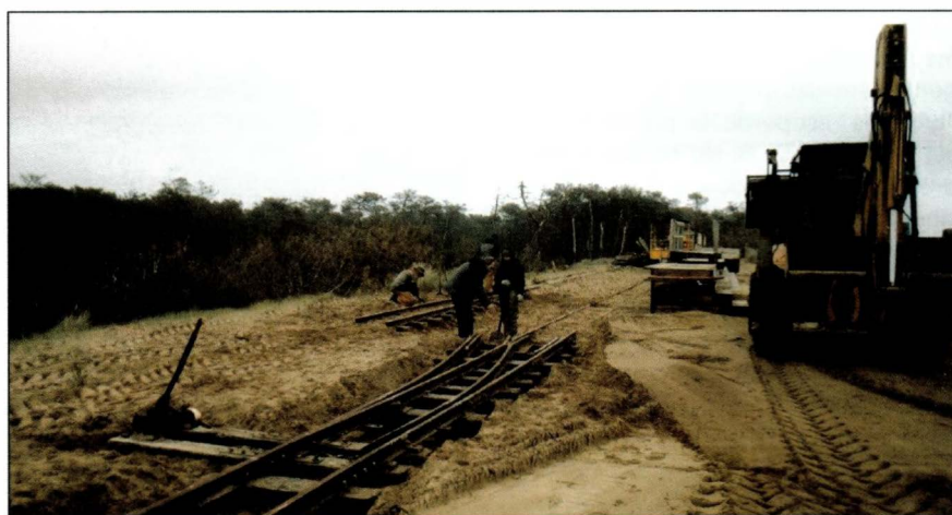
STTST - Les travaux de reconstruction au 24 mars 2020. Cliché STTST
