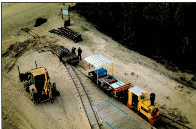
STTST - Le terminus de Maumusson au 25 février dernier. La voie est dans le vide, là où il y avait encore 15 m de plus. Cliché Photodrone17 - STTST
