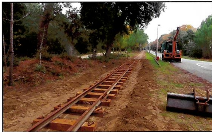
St Trojan – Travaux de renouvellement de voie. La particularité sur ce réseau est la pose dans le sable, sans ballast. Cliché STTST
