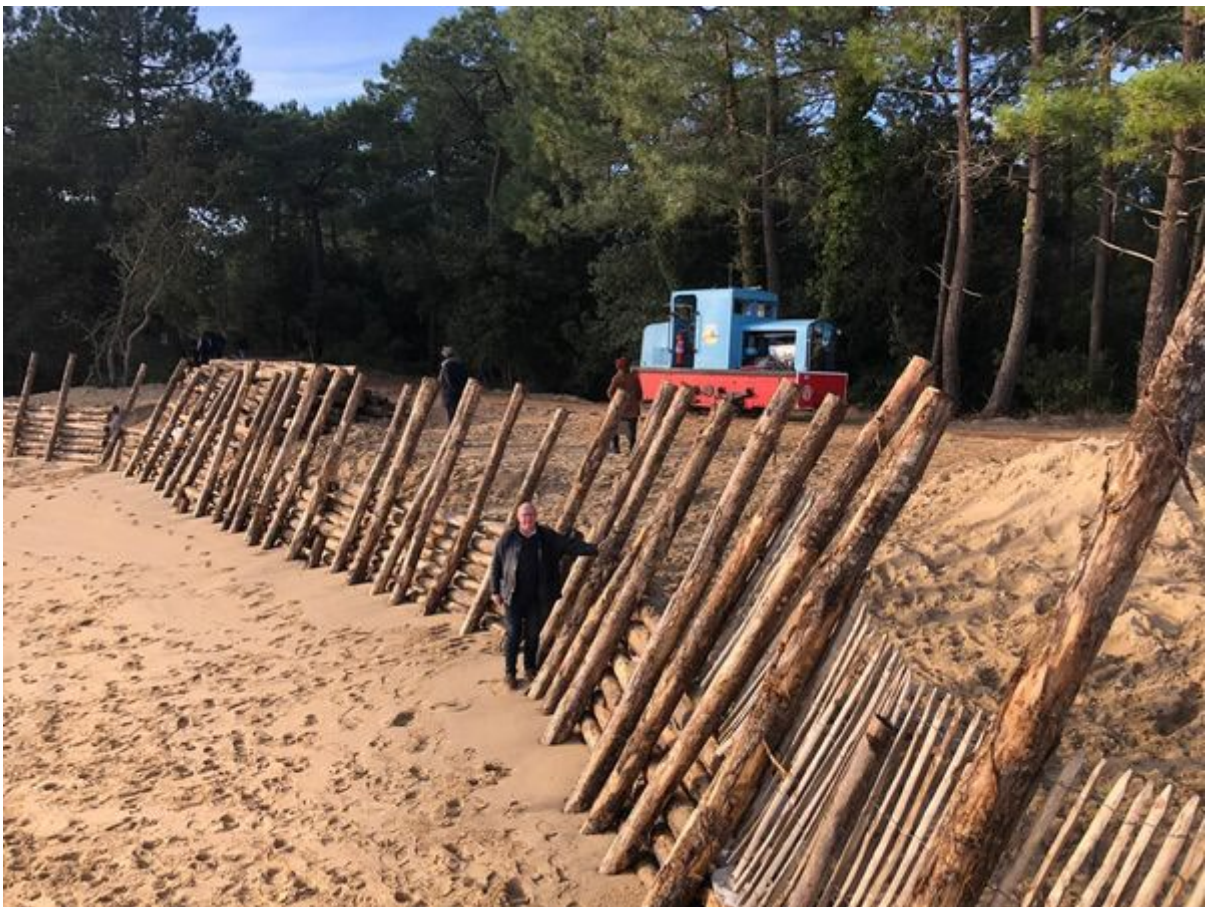
Les travaux de sécurisation des rails peuvent reprendre à Saint-Trojan © Radio France - Sophia Berrada
